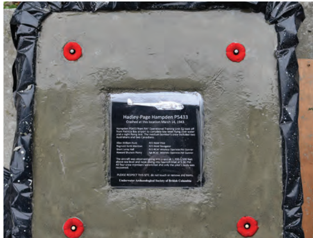
Plaque after concrete pour
